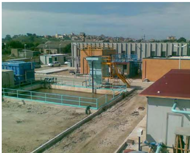
REALIZZAZIONE DELL'IMPIANTO DI POTABILIZZAZIONE DI GELA
