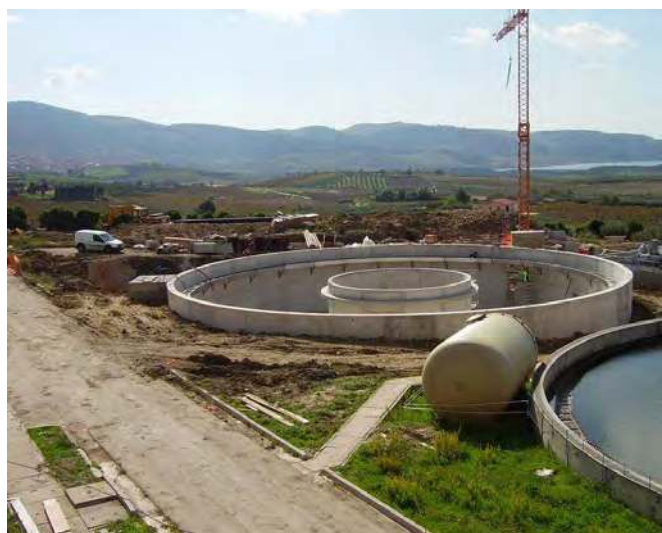
POTENZIAMENTO DELL'IMPIANTO DI POTABILIZZAZIONE DI SAMBUCA
